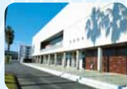
宮崎県体育館
